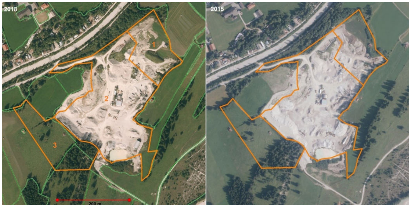
Abb. 13: Die Kiesgrube Achner auf den Orthofoto 2018 mit den aktuellen landwirtschaftl. Feldstücken (li) und das Luftbild von 2015 (re).
